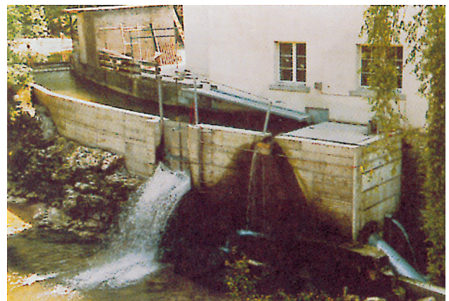
Figura 4.1 b) - Veduta generale dell'impianto dopo l'ammodernamento.
