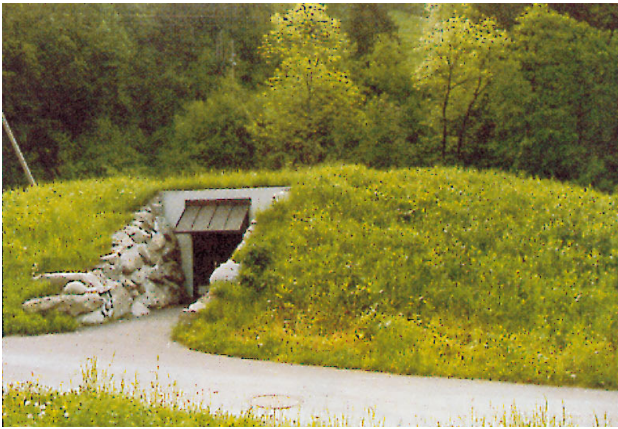
Figura 3.8 - Piccola centrale (250 kW) di Pont de la Tine (VD) totalmente interrata.
