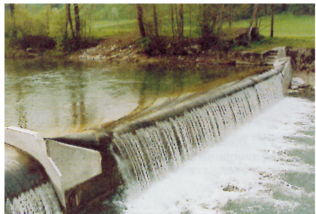
Figura 2.4 - Esempio di sbarramento in gomma sull'Ilfis a Bärau nei pressi di Langnau (BE).
