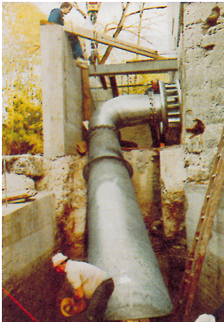
Figura 4.2 a) - Montaggio dell'insieme diffusore - aspiratore della turbina Kaplan.
