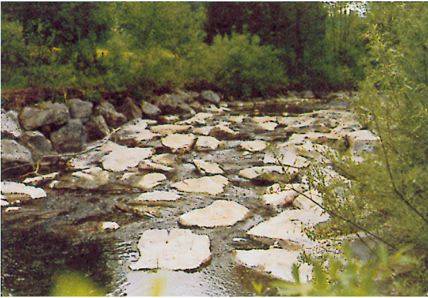
Figura 3.4 - Rampa di rallentamento costituita di blocchi in sasso nel Röttenbach presso Eggiswil.
