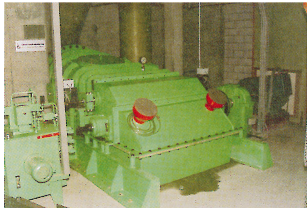
Figura 4.5 - Turbina a flusso trasversale.
