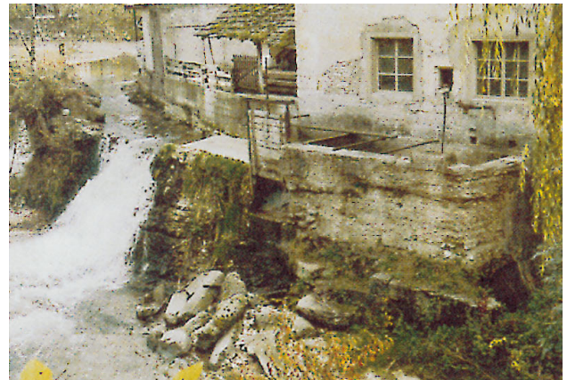
Figura 4.1 a) - Veduta generale dell'impianto prima dell'ammodernamento.
