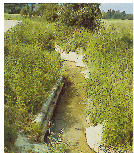
Figura 3.3 - Correzione del corso di un ruscello nel Mittelland bernese attraverso tecniche naturali; durante la costruzione (foto in alto) e un anno dopo.
