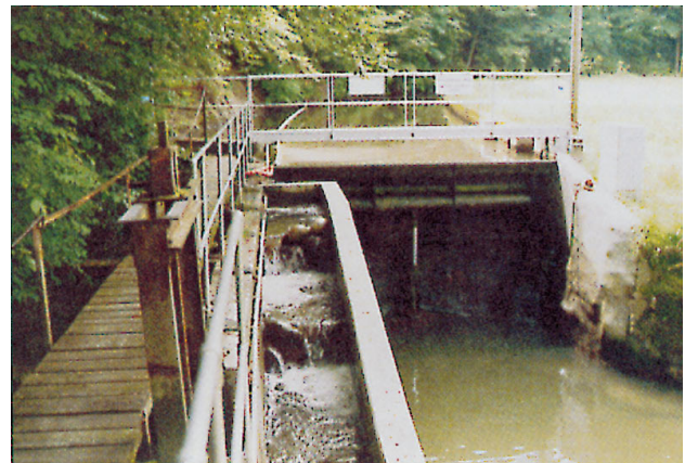
Figura 2.3 - Esempio di presa d'acqua laterale con regolazione della ritenuta per mezzo di sbarramento a saracinesca, sul Rothbach nei pressi di Hüttwill (BE).
