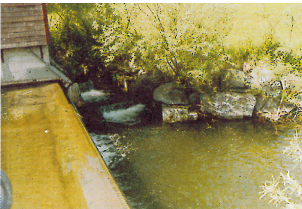
Figura 3.6 - Entrata di un ruscello di aggiramento a valle di uno sbarramento a Kleindietwil (BE).
