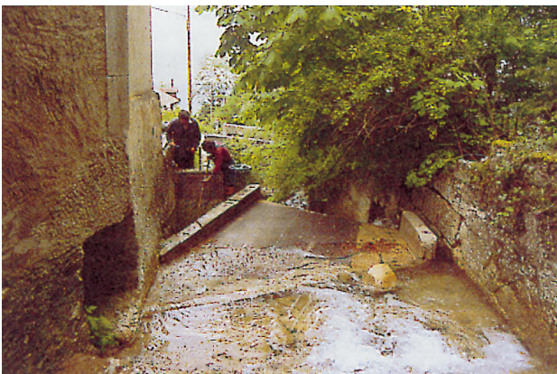
Figura 2.5 - Esempio di una presa d'acqua tirolese a griglia orizzontale che preleva l'acqua per una piccola centrale a Baulmes (VD).
